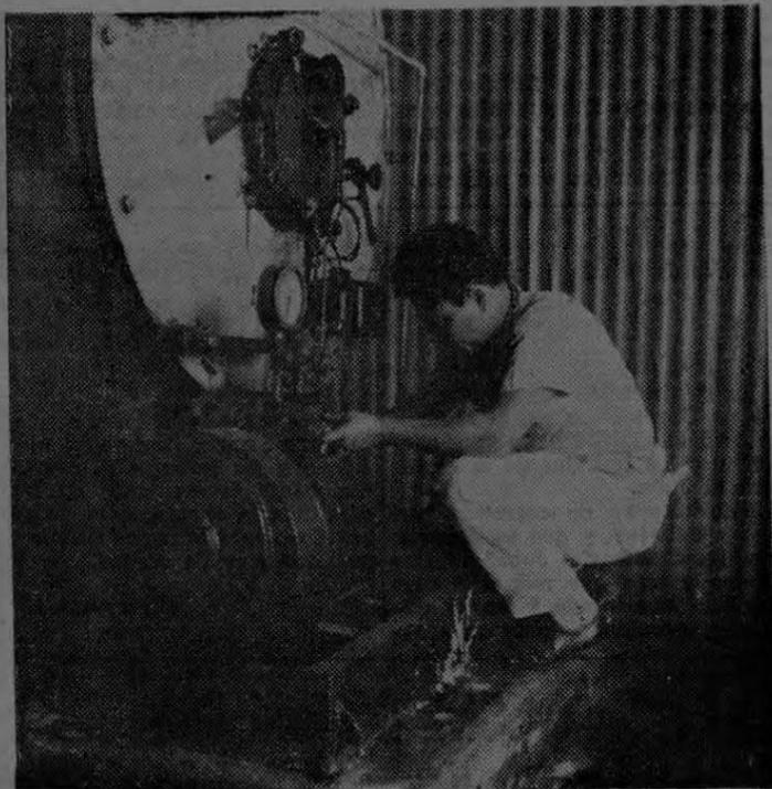
Entre otras obligaciones, Julio César Ortiz Márquez tiene que mantener en perfecto estado de funcionamiento el cuarto de calderas, compresores, condensadores y esterilización. En la gráfica lo vemos ajustando una válvula de uno de los compresores.
